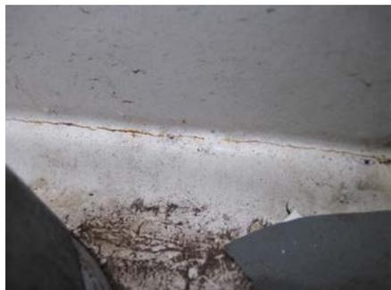
Abb. 19: Riss in Turmschweißnaht.
