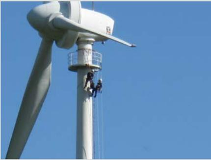
Abb. 2: Prüfung Turmaußenseite.
