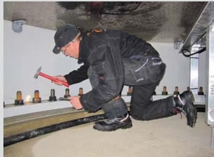
Abb. 5: Sicht- und Lockerheitskontrolle.
